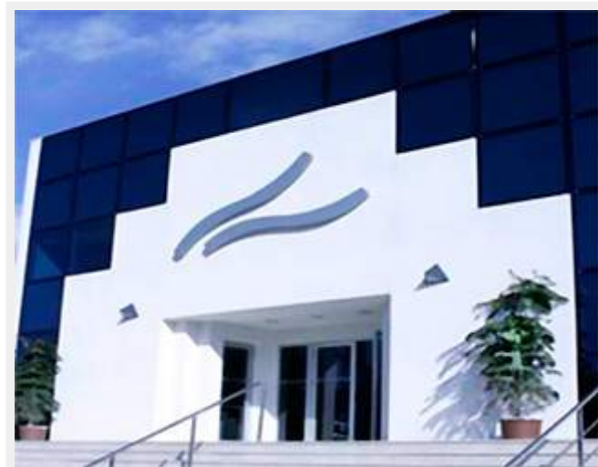
Centro deportivo Inacua
