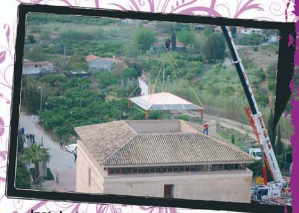
Instalación de la pérgola de la Torre Vieja de El Paraje
