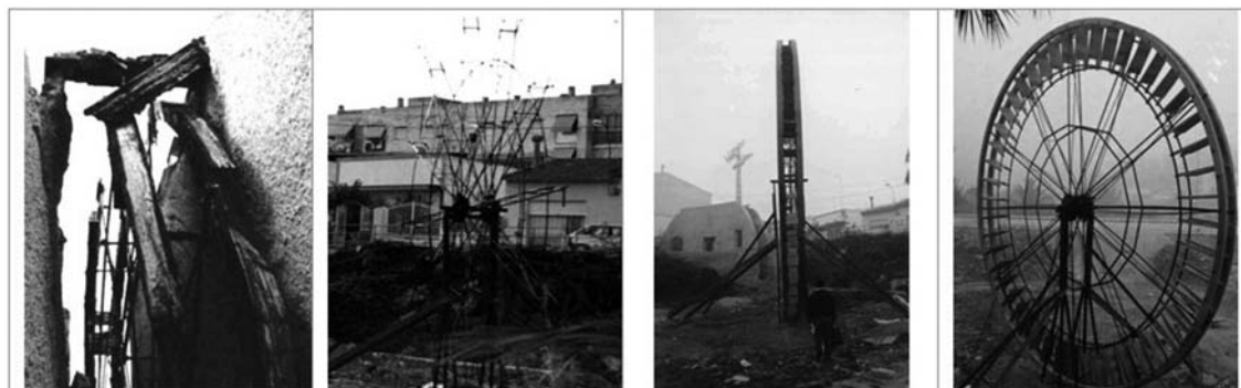
Figura 13. Proceso de la restauración de la noria de Los Semolicas, cedidas para formar parte del estudio realizado en el PFC por D. José Montoro Guillén, arquitecto responsable de la intervención.
