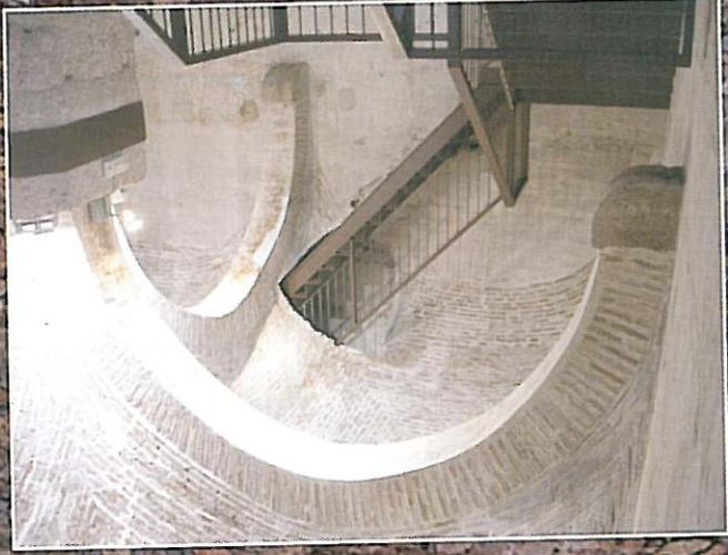
El edificio que ha llegado hasta nosotros es el original, a excepción del remate (pretil y almenas). Tiene planta cuadrada (12,90 m de lado) y alcanza una altura aproximada de 21 m. Sus muros son tapias de mortero de cal de 1,60 m de espesor.
