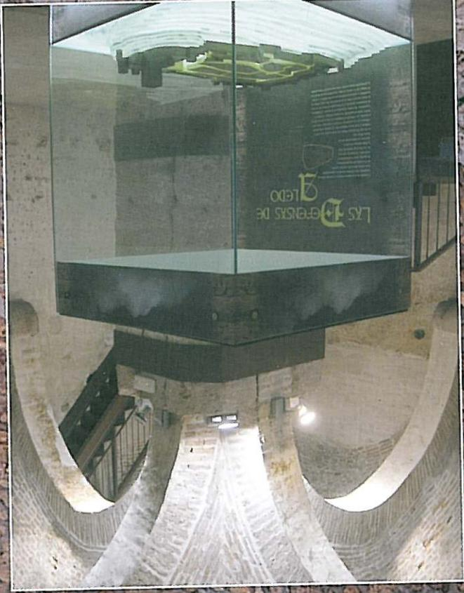
Las dos plantas superiores muestran un diseño similar: cada una está cubierta por cuatro bóvedas esquinadas de ladrillo sobre otros tantos arcos central y en ménsulas de piedra empotradas en las paredes (ménsulas de cuarto de bocel liso y de rollos). Mientras en la primera planta sólo se abrieron saeteras de buzón para iluminar, en la segunda hay diferentes vanos para vigilancia, iluminación y defensa.
