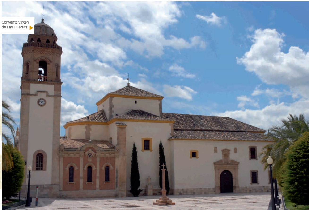
Detalle del exterior
